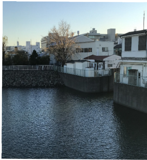
↑旧呑川水門 昭和島側から
