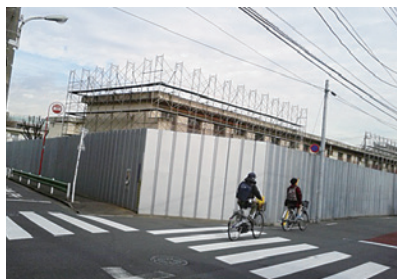
解体中の気象庁職員宿舍跡地
